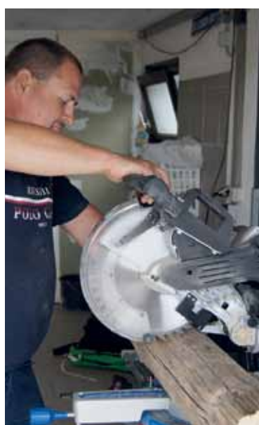
und der Balken wird auf Maß gesägt
